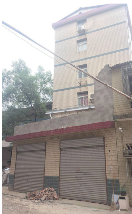
▲屋顶上违建的钢架结构建筑已被拆除 记者 贺天鸿 摄
