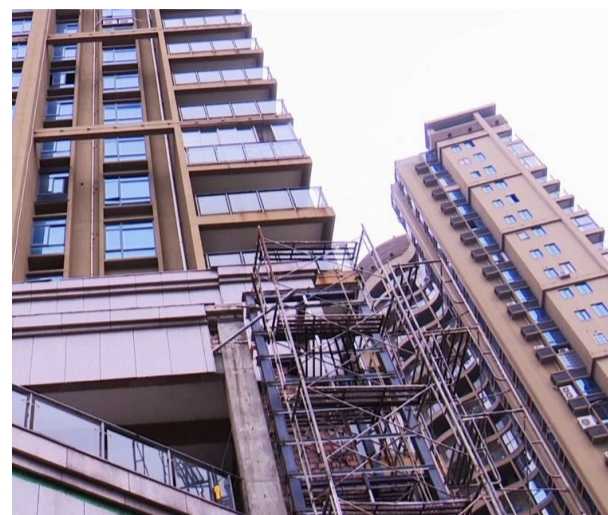
▲业主加装电梯的施工现场 记者 陈驰 摄
