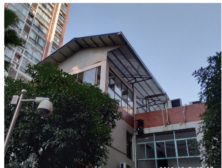
▲会所楼顶搭建的钢结构棚屋 记者 姚时美 摄
