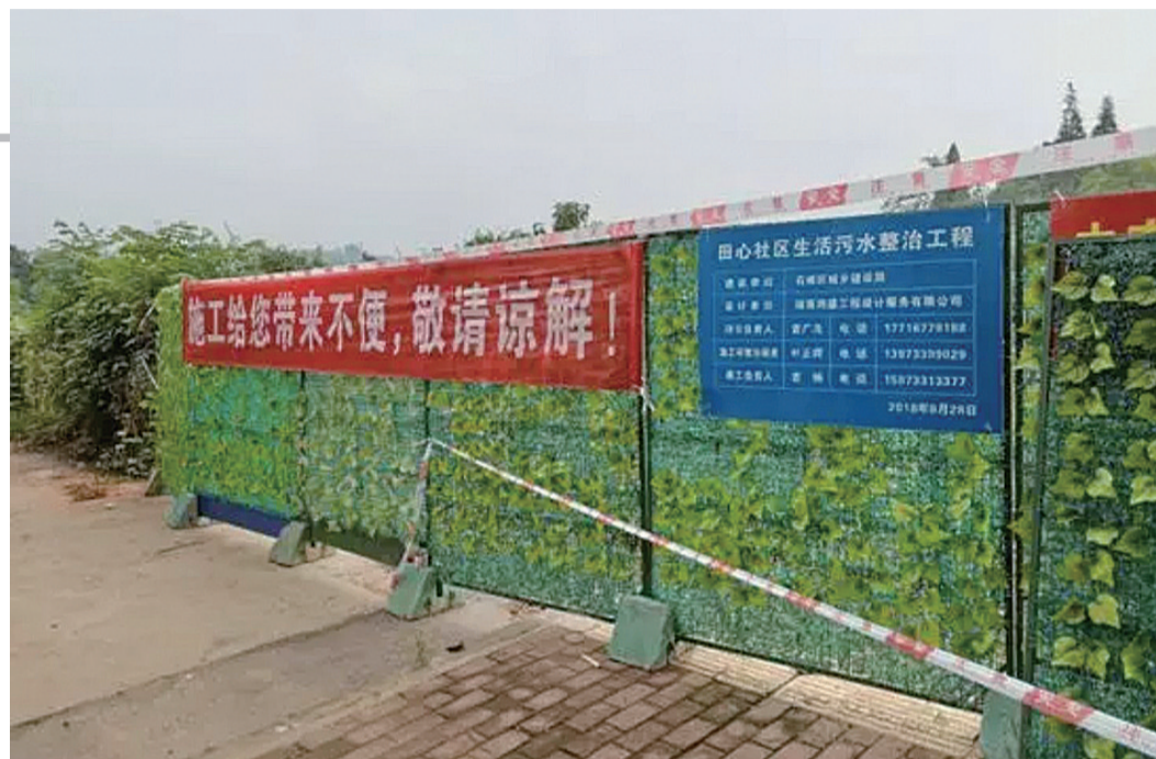
▲生活污水处理站正在施工 通讯员供图
