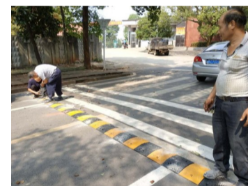
▲工人正在安装减速带 记者 戴凛 摄
