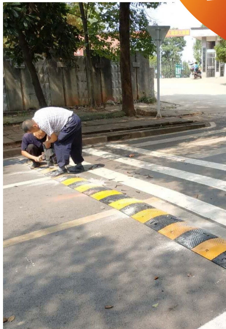
▲工人正在安装减速带 记者 戴凛 摄
