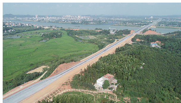
▲修建中的龙洲路 通讯员供图
