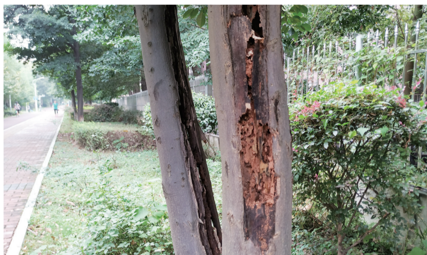
▲被白蚁侵蚀的行道树 记者 姚时美 摄
