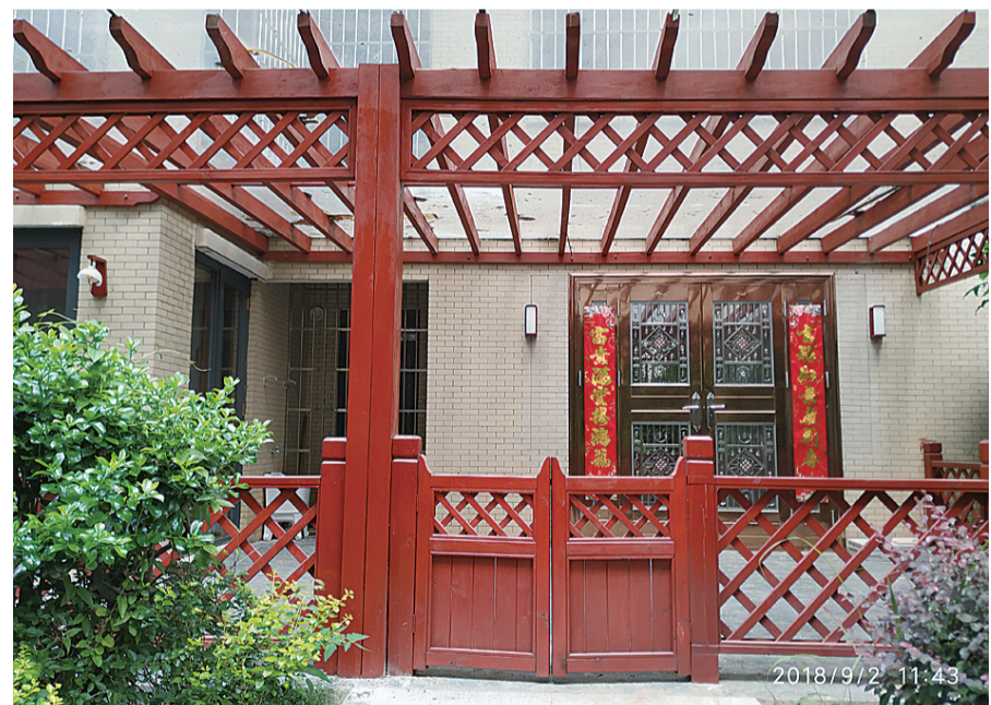
▲颐景园小区内一楼业主自建建筑物 记者 姚时美 摄
