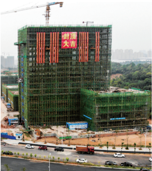
▲国投·轨道智造产业园 通讯员 丁明 摄
