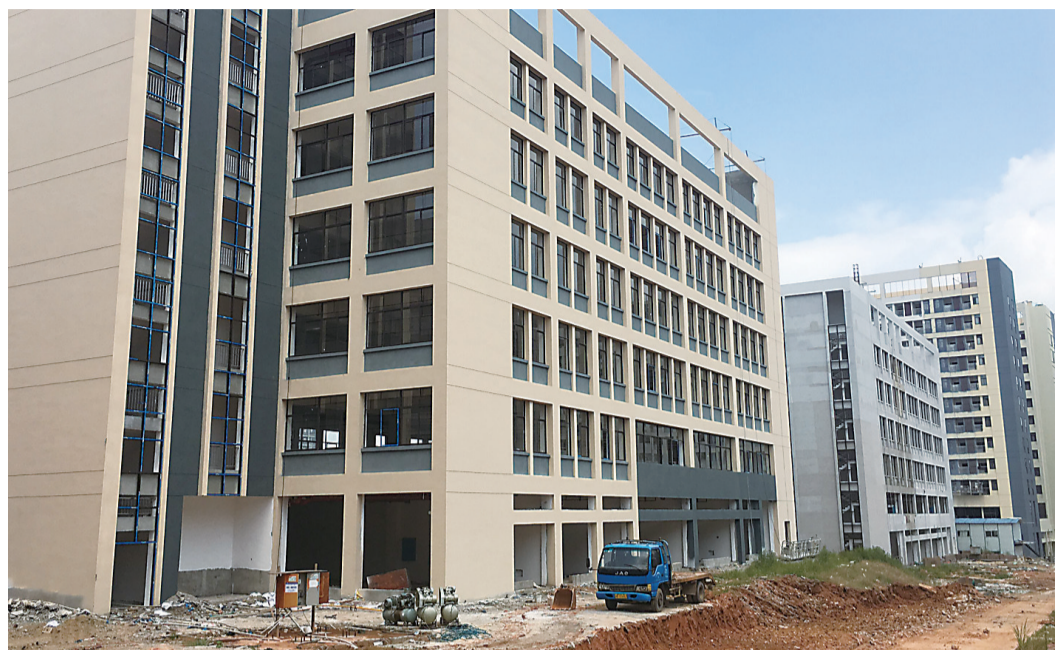
▲项目二期部分厂房外墙已完成粉刷 记者 戴凇 摄
