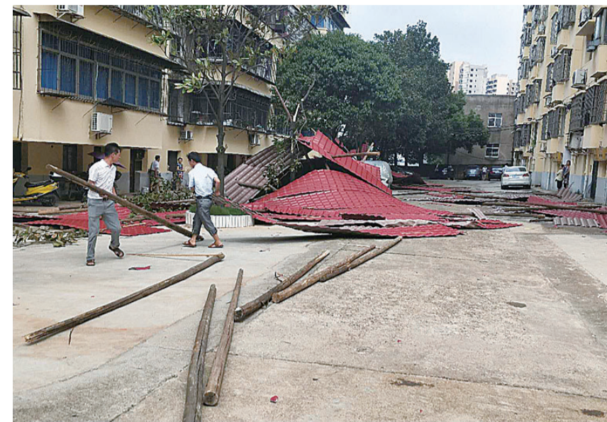
▲施工人员正在清理掉落的隔热层和木梁 受访者供图
