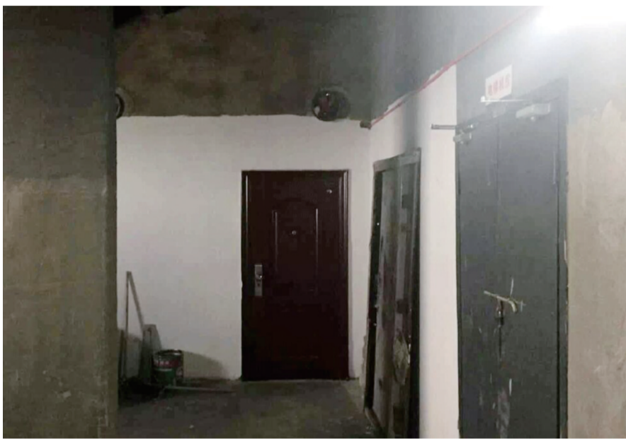
▲隔热层被违规改建 记者 陈驰 摄
