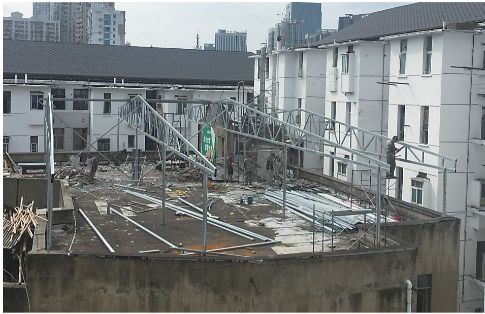
▲前天上午9点多,施工人员在楼顶搭建钢架 记者 陈驰 摄
