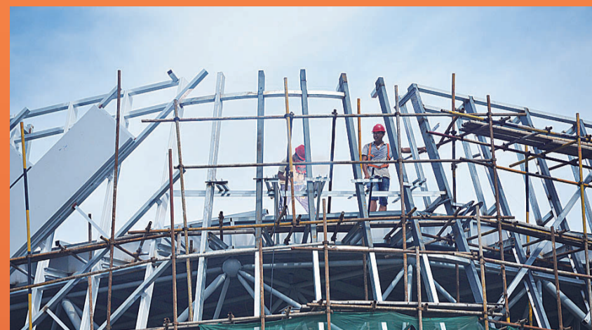
▲汽博园汽车交易中心施工现场,工人师傅正在焊接
