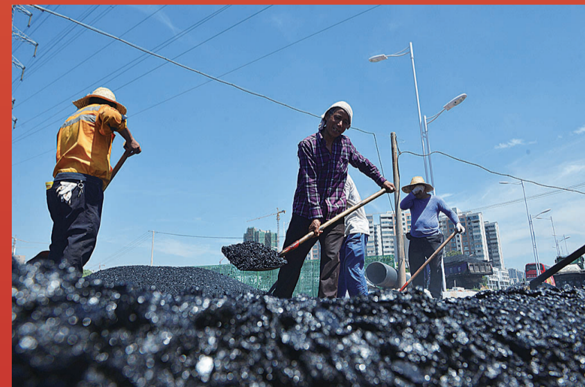
▲神农大道A段建设现场,工人师傅正在铺沥青
