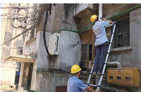
▶工作人员为老人修复水管 市自来水公司供图
