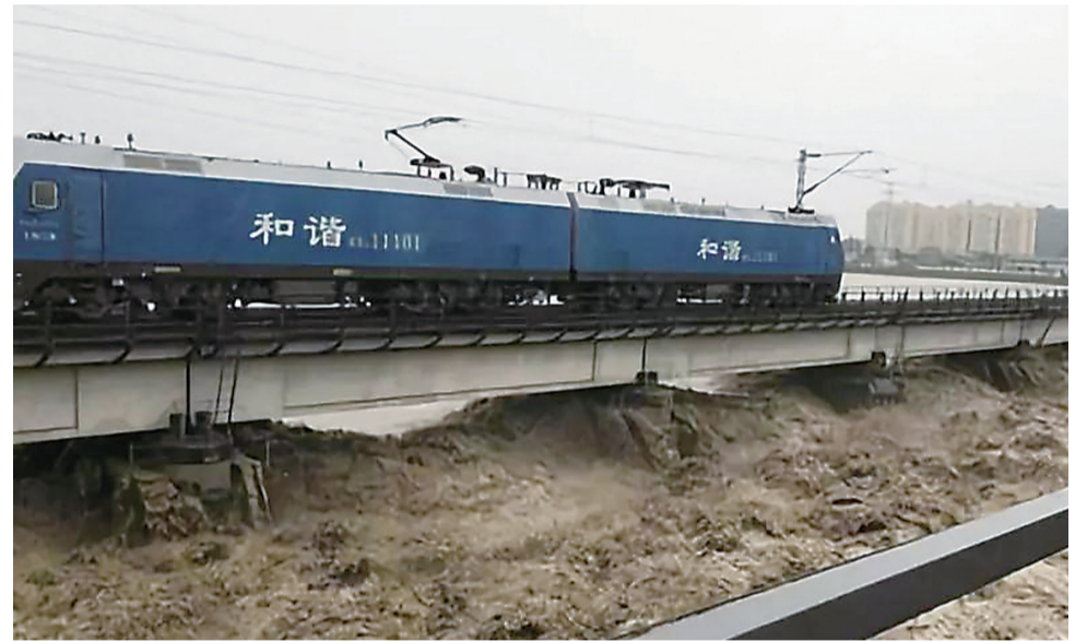
▲由中车株机研制的重载电力机车,开上宝成铁路涪江大桥“压梁镇洪” 中车株机供图
