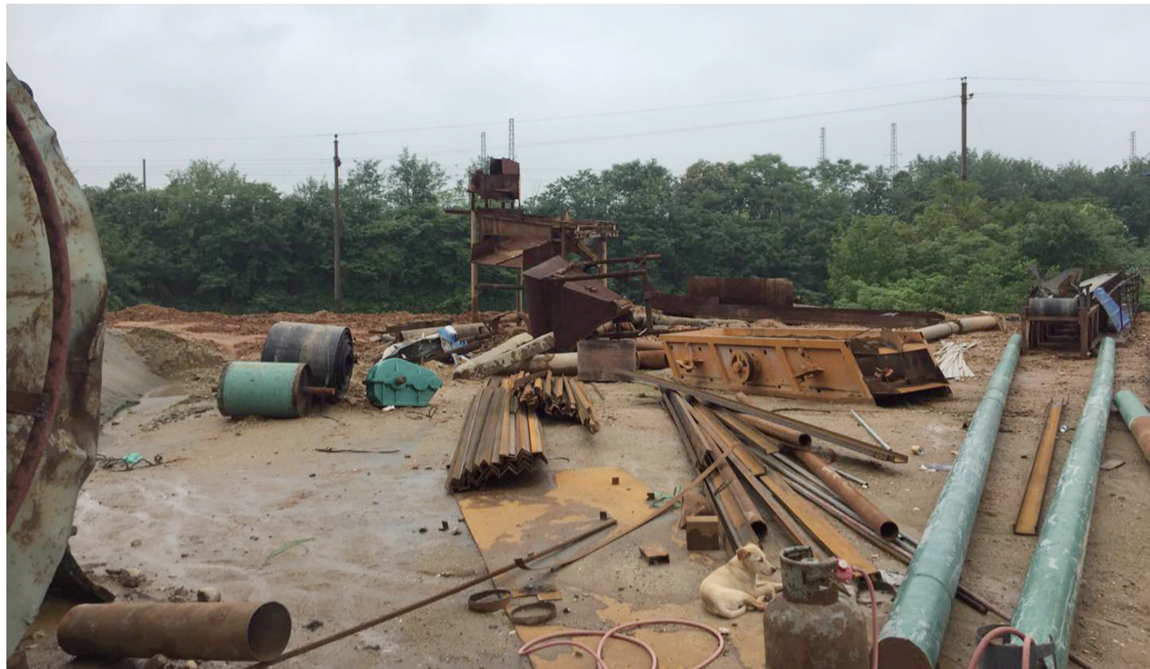
▲图为株洲县南洲镇拆除的洗砂场 记者 赵露 摄
