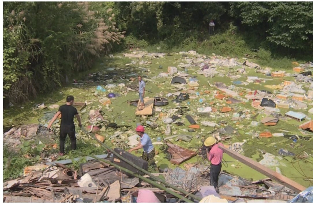
▲工人们正在清理水塘内垃圾 记者 陈驰 摄
