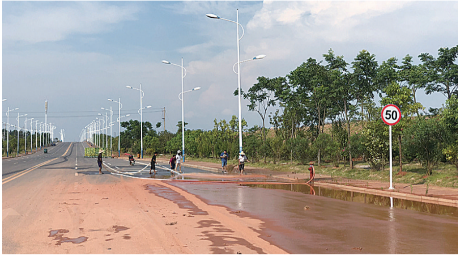
▲栗雨工业园内一工地,泥水顺势流入打开的雨水井内 记者 伍靖雯 摄
