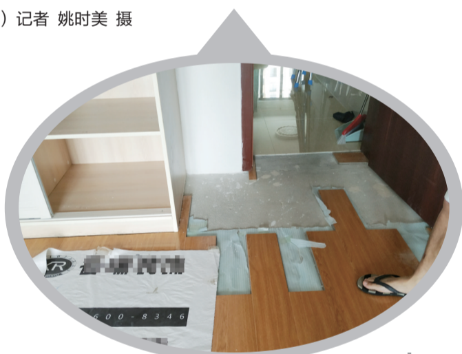
▲黄女士家木地板翻修还未完工 记者 姚时美 摄
