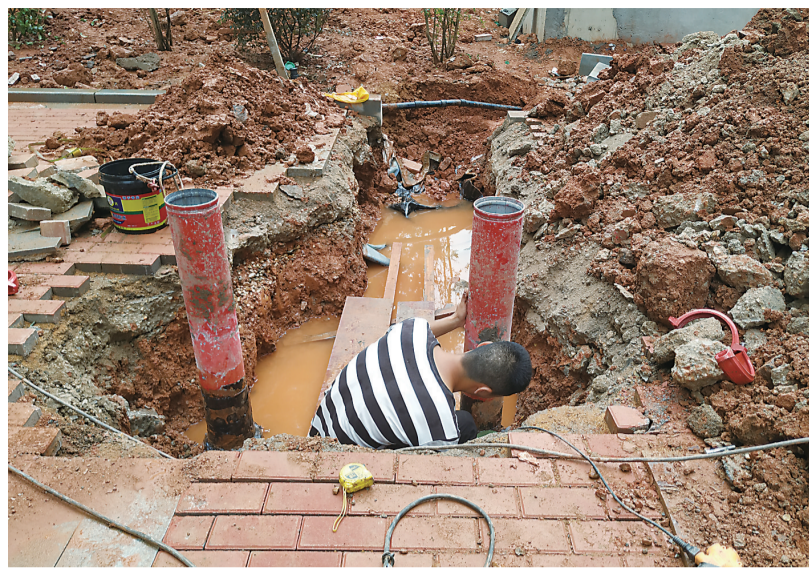
▲小区内消防水管还在施工
