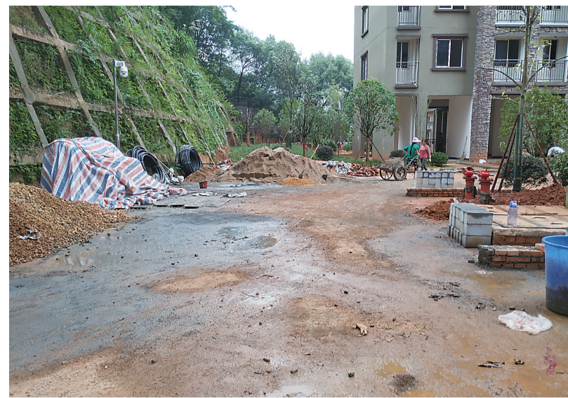
▲小区内道路是水泥路,工人正在施工 记者 姚时美 摄
