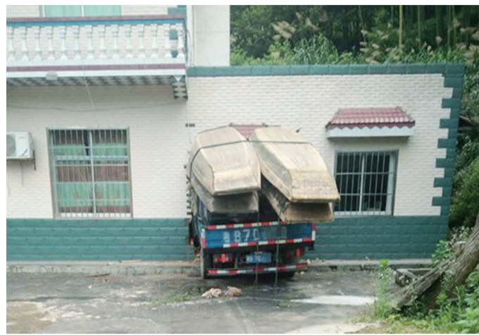
▲货车撞毁民房墙壁冲进房内 通讯员供图
