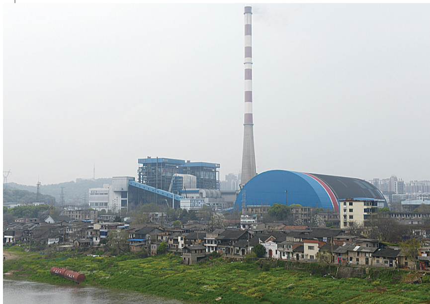
▲不久的将来,株洲电厂这根高240米的烟囱或将消失 记者 刘震 摄
