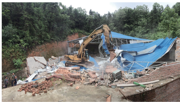
▲拆违现场 通讯员供图
