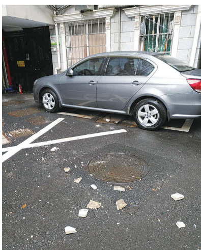
▲车顶被石膏块砸出凹陷 记者 成姣兰 摄
