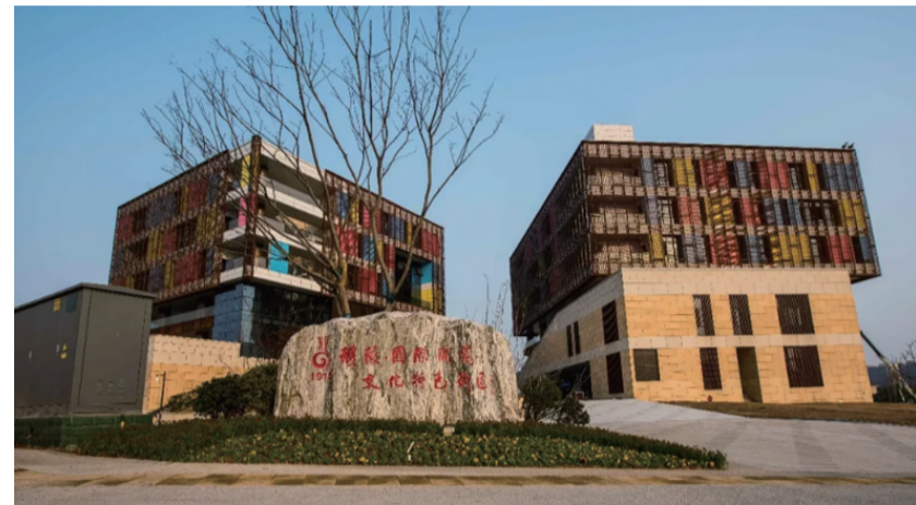
▲正在建设中的醴陵“1915”国际陶瓷文化特色街区 通讯员供图
