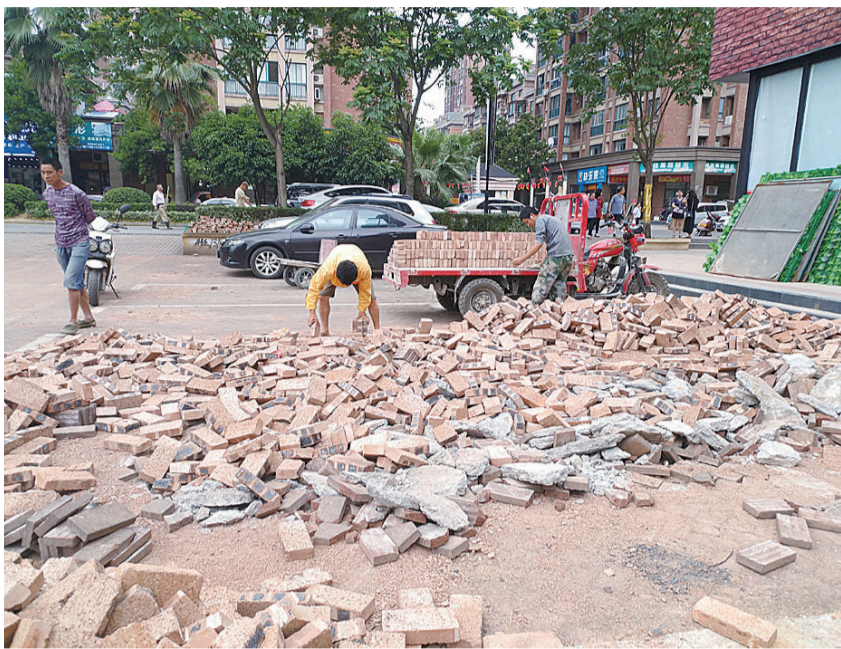
▲前坪被开挖现场 记者 姚时美 摄
