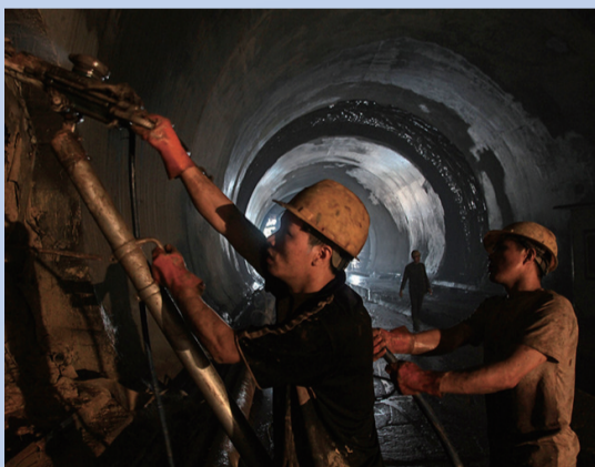
▲2012年6月9日,贺家冲隧道里钻山的汉子
