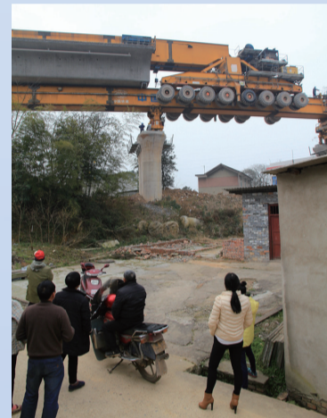
▲2016年1月3日,鸭婆塘特大桥架梁,群众驻足围观
