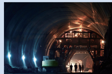
▲2013年1月16日,贺家冲隧道建设现场
