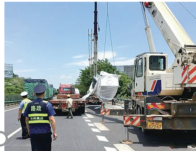
▲吊车将被甩出的电梯吊起转运 通讯员 毛有钧 摄
