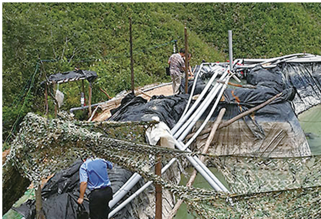
▲为躲避卫星监控,沉淀池周边拉起了许多迷彩布。图为检察官对现场进行调查 受访者供图
