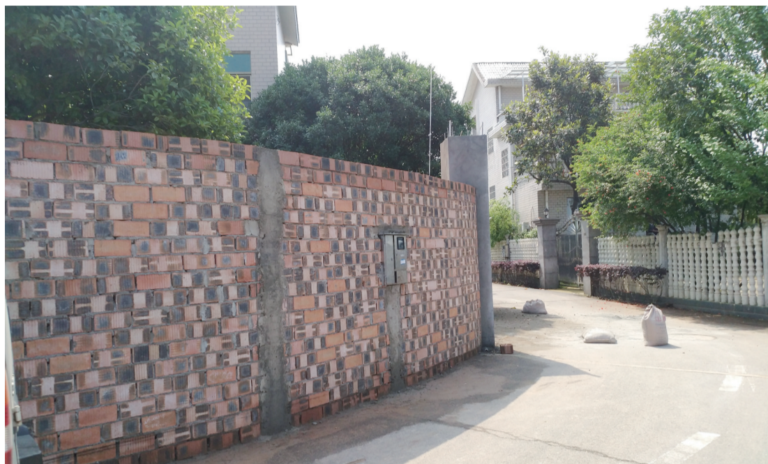
▲新砌的围墙主体已经成形 记者 姚时美 摄
