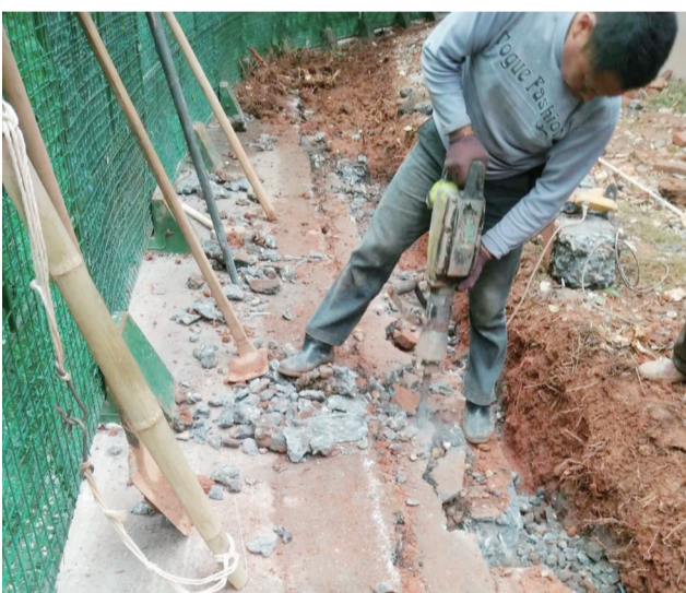
▲施工时,马路路基被挖掉 受访者供图
