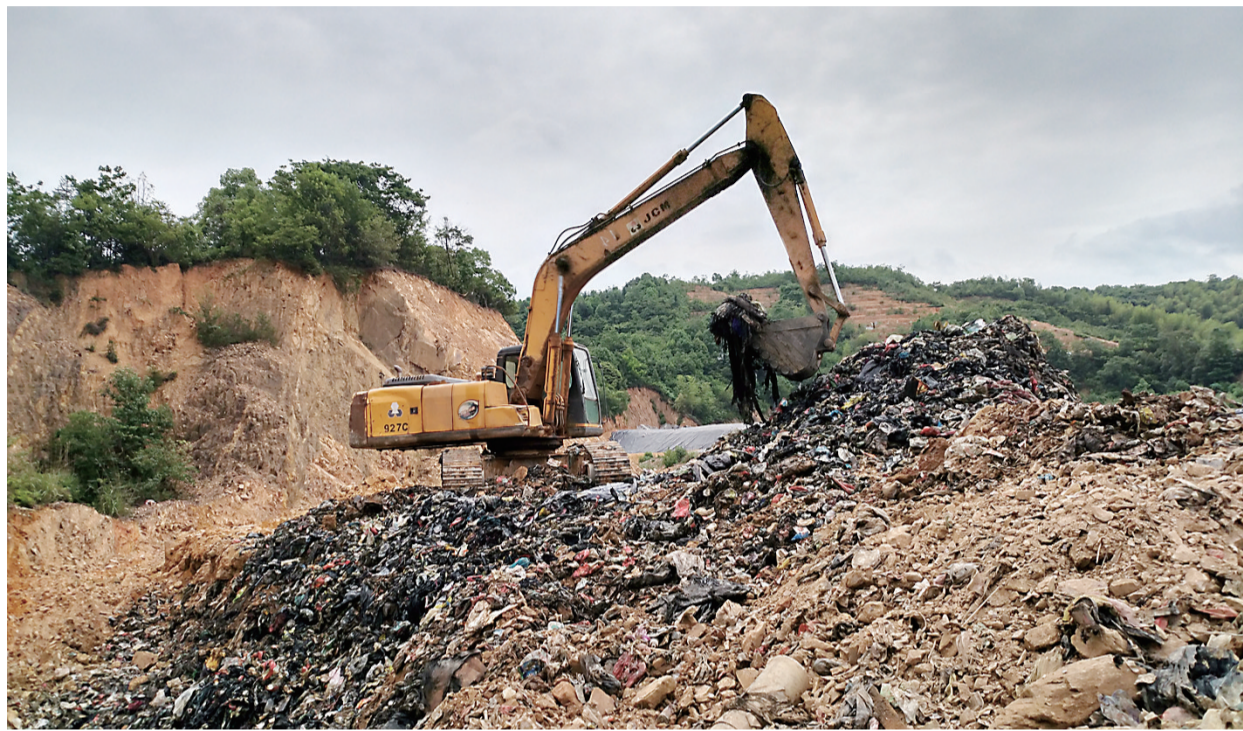
▲5月2日,一台挖掘机正在南郊垃圾填埋场施工 记者 姚时美 摄
