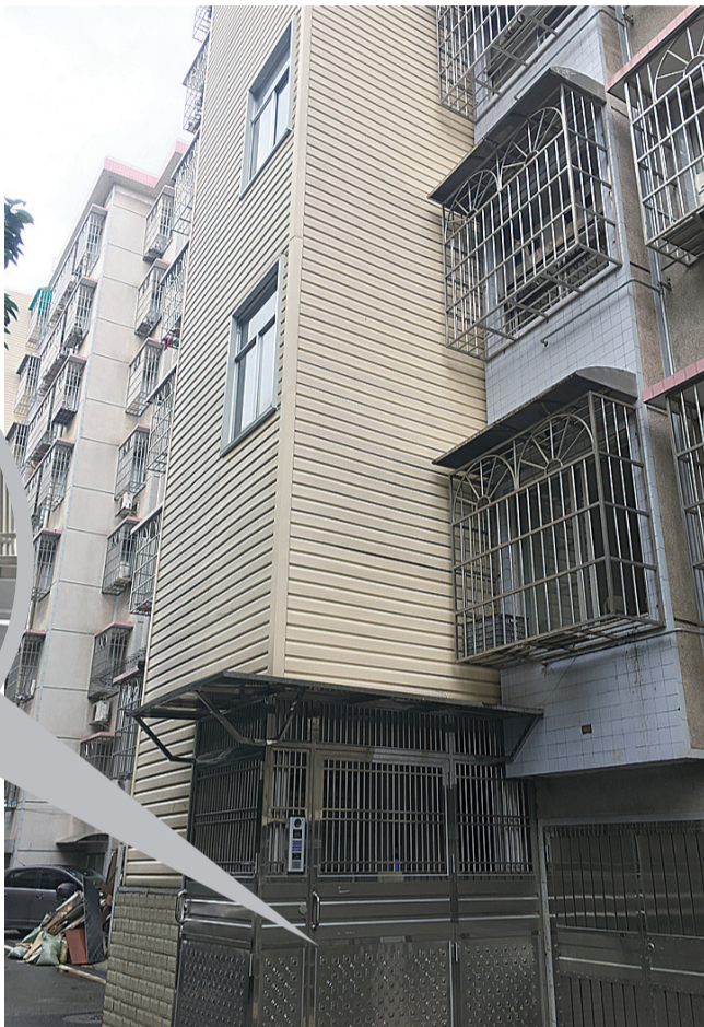
▲株洲某小区,加装电梯的外景 记者 成姣兰 摄
