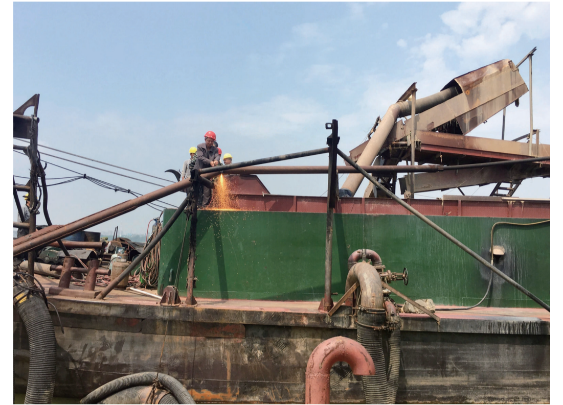
▲施工人员正在拆卸吸砂装置 记者 戴凇 摄
