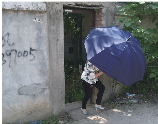
▲另一个出入口,目测宽度不足1米 记者 贺天鸿 摄
