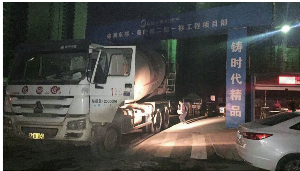
▲东部美的城夜间施工被查处现场 记者 赵露 摄
