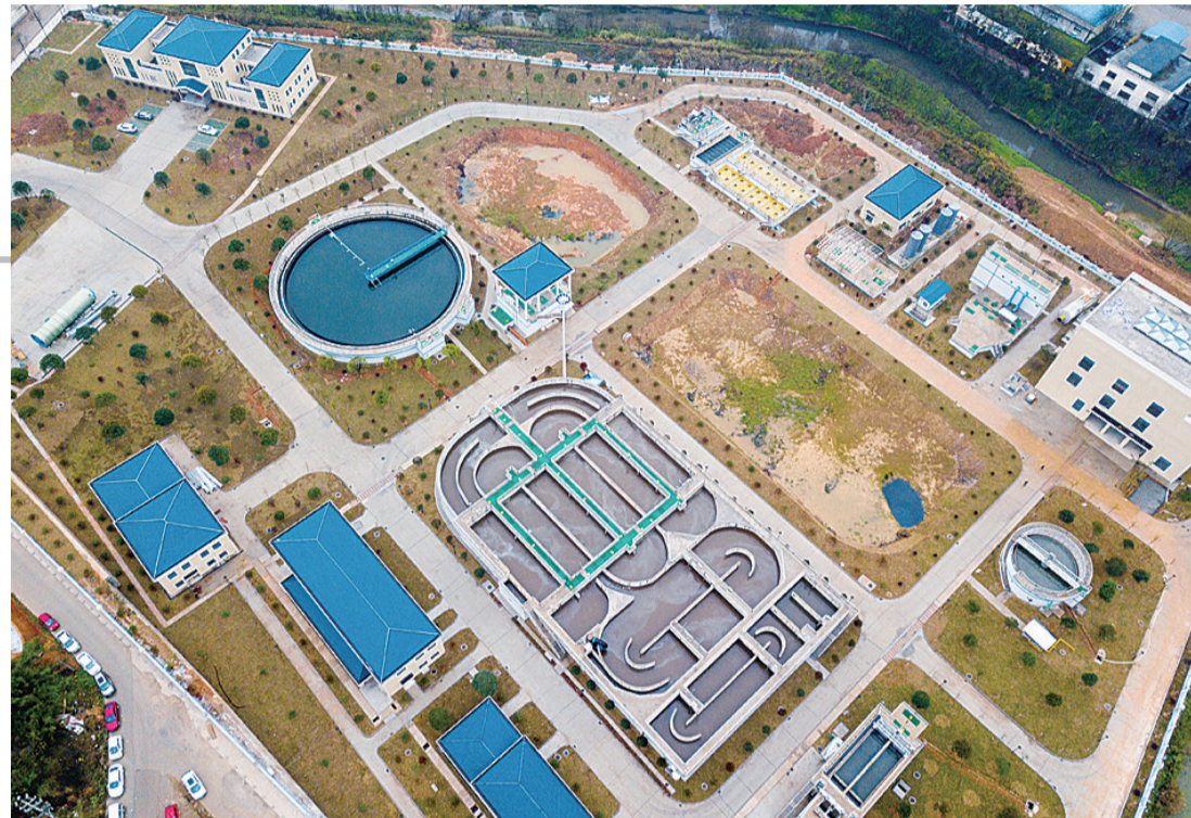
▲枫溪污水处理厂(资料图) 记者 刘震摄
