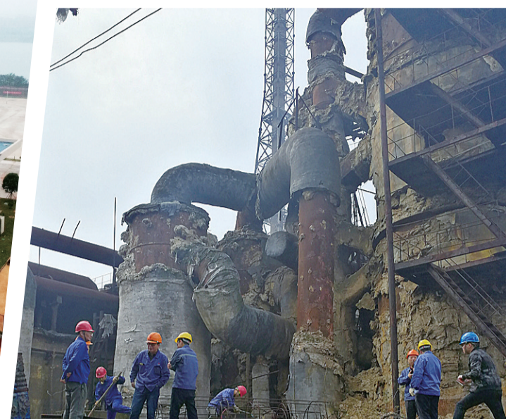
▲昨日,株化硫酸厂,拆除现场 记者 李卉 摄
