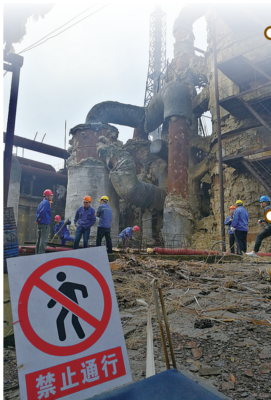
▲昨日,株化硫酸厂内,专业团队正在对部分装置进行拆除 记者 李卉 摄
