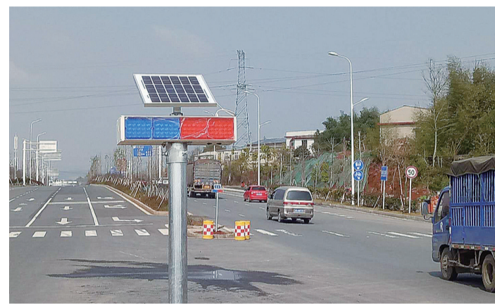
▲水园路口安装的爆闪灯和防撞桶 记者 成姣兰 摄
