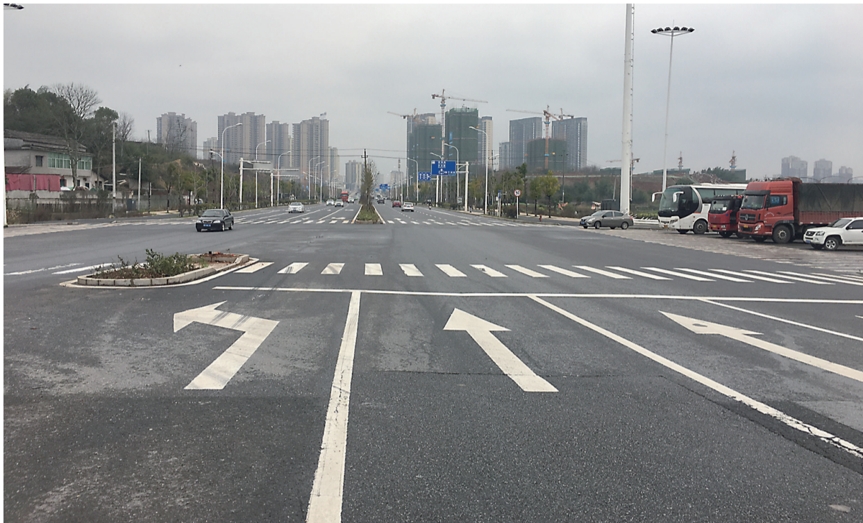
▲路口画线情况,直行车道左侧部分与对面的绿化带重叠 记者 成姣兰 摄
