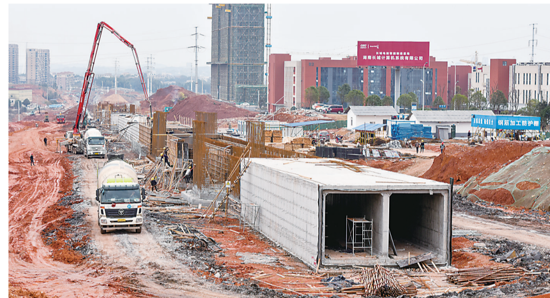
▲西站南路综合管廊工程施工现场 记者 刘震 摄
