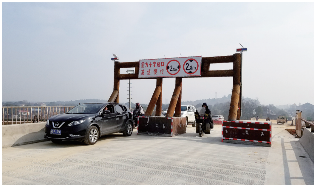
▲昨日,不少车辆选择通过航电枢纽跨闸桥过江 通讯员供图
