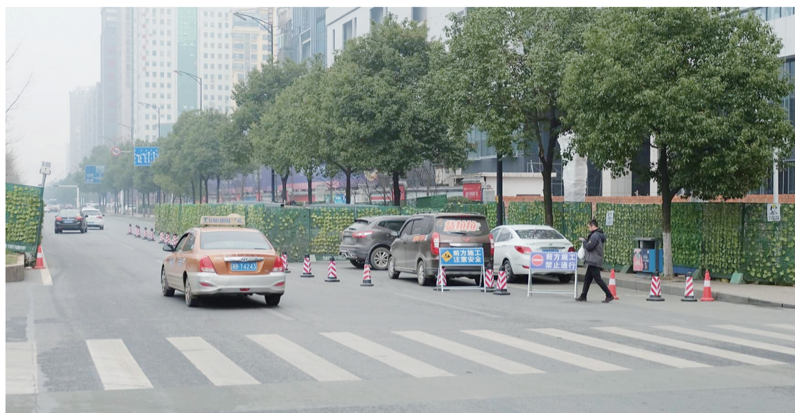
▲庐山路人行天桥架梁,今明道路分时段管制 记者 肖蓉 摄
