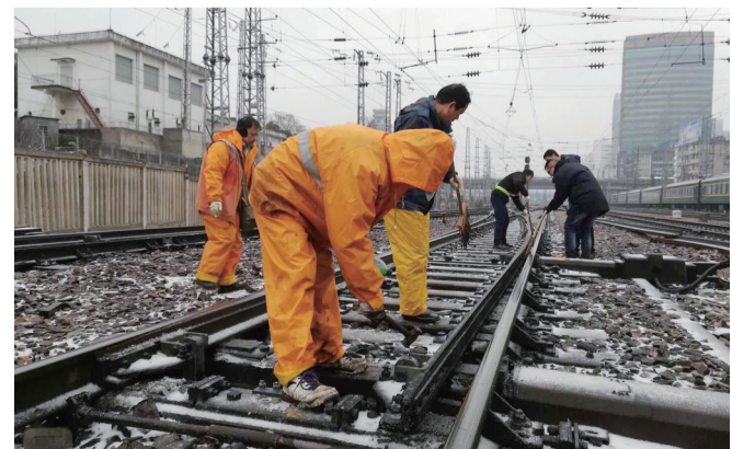
▲铁路职工在冰雪天气进行巡查检修 株洲车站 供图
