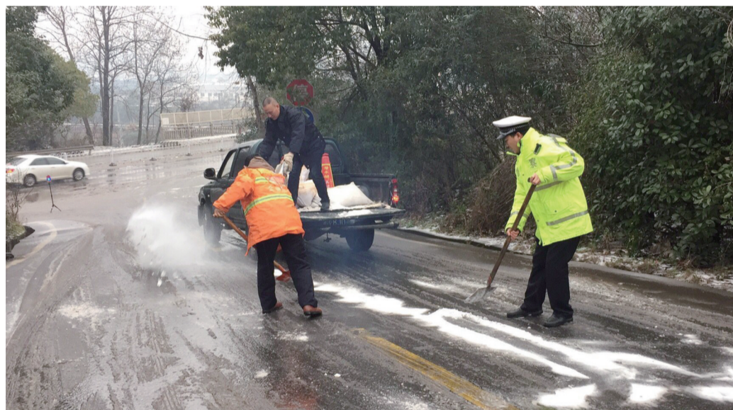
▲石峰交警和市政人员在路面撒盐除冰保障行车安全 石峰交警供图
