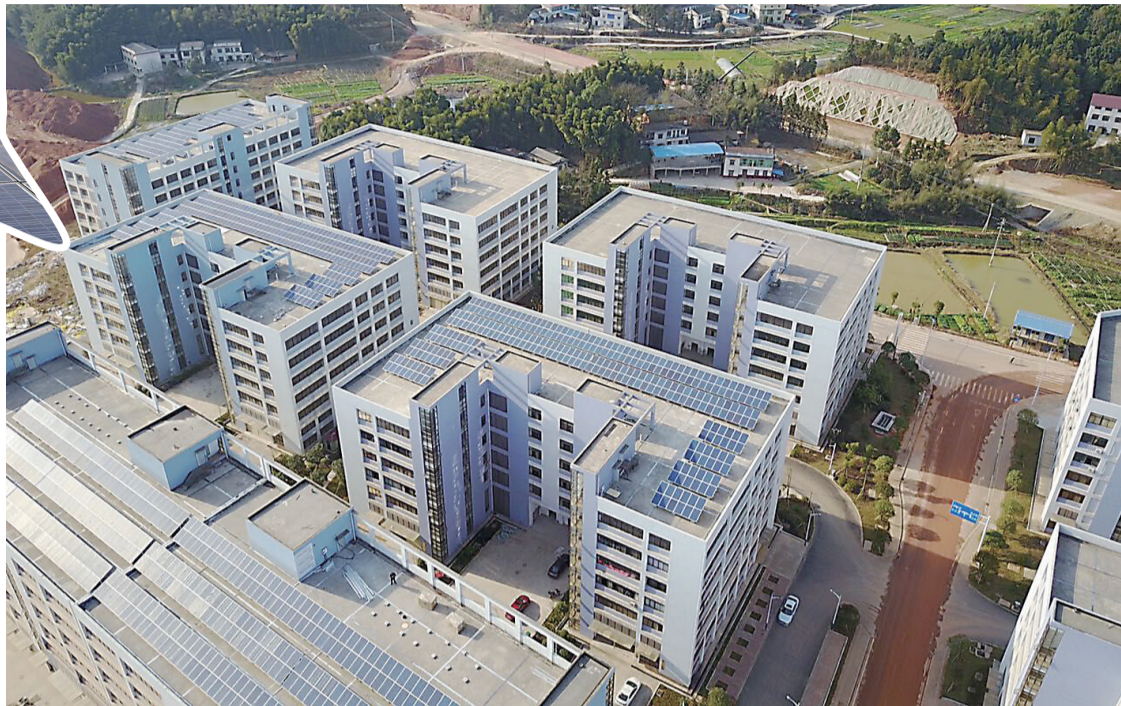
▲新芦淞(白关)国际服饰产业园楼房屋顶安装了光伏发电设备 通讯员供图
