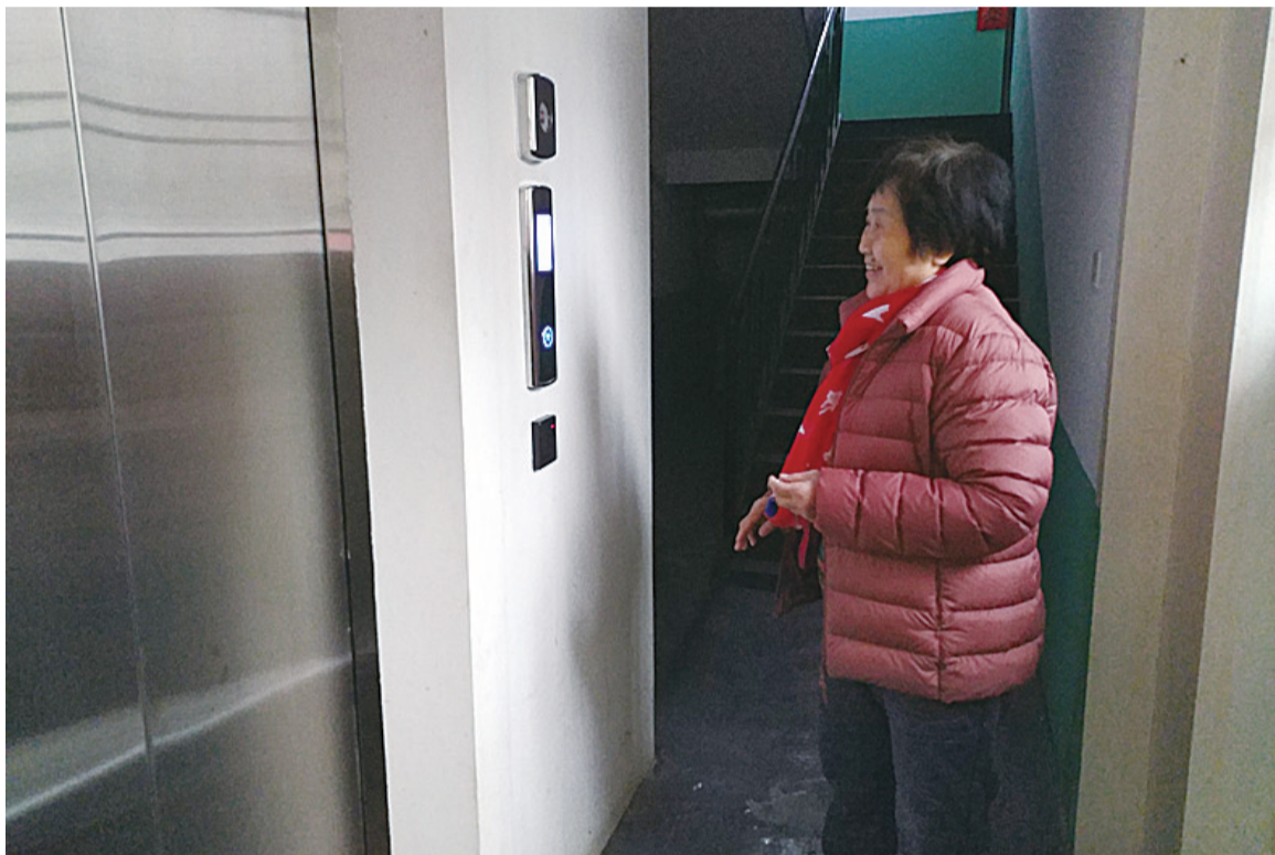
▲市财政局大院住宅楼梯房，已成功加装电梯，为老小区改造提供了经验(资料图) 记者 姚时美 摄
