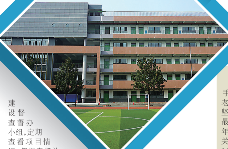
九方小学新建教学楼
