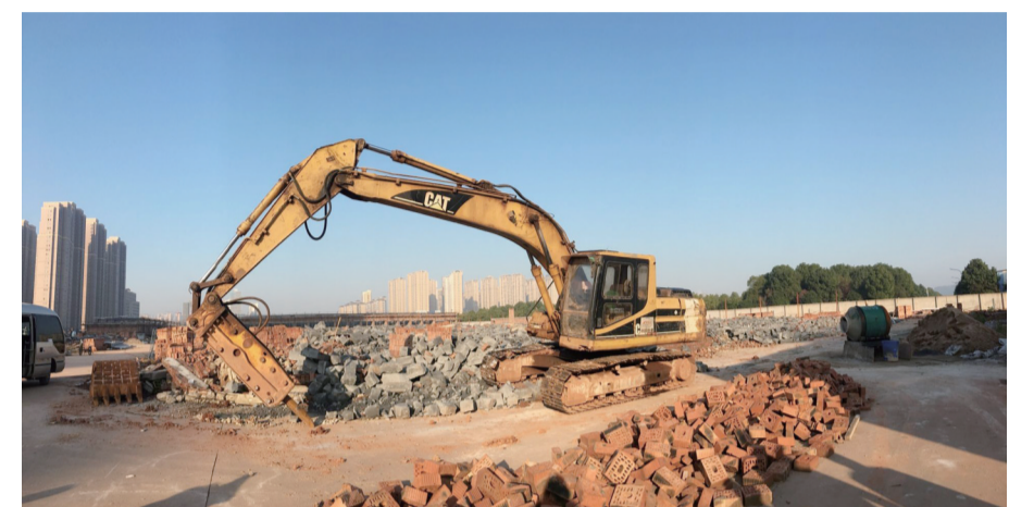
▲金德工业园内,5000平方米违建“满江红农贸市场”已被拆除 记者 肖蓉 摄
